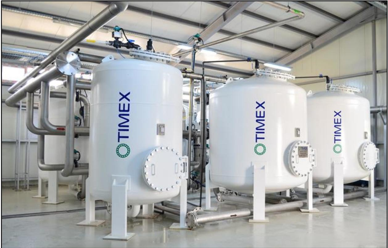
Запорные клапаны фильтров, впускные и выпускные коллекторы, коллекторы, фитинги и соответствующее оборудование, полная автоматизация всего комплекса входили в объем поставки. Панель управления PLC с системой SCADA была разработана и поставлена собственными силами для управления всеми приводными технологическими клапанами и контрольно-измерительными приборами.
